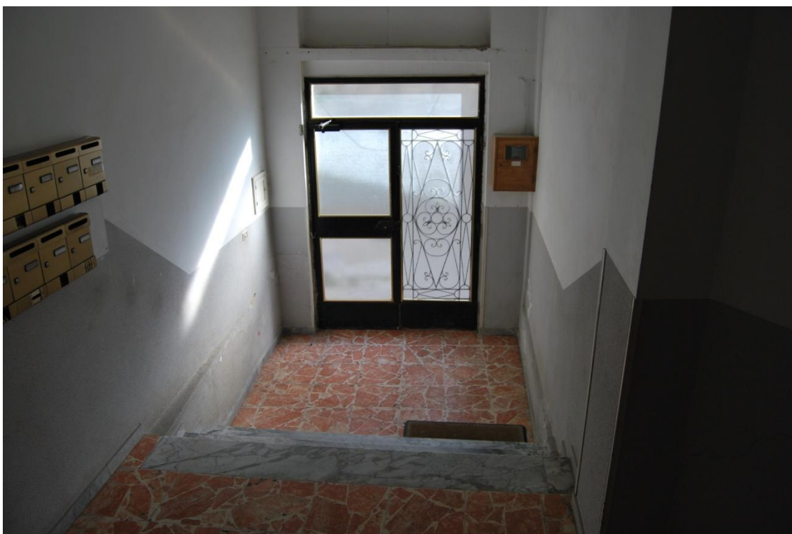
Veduta interna dell'ingresso del condominio
